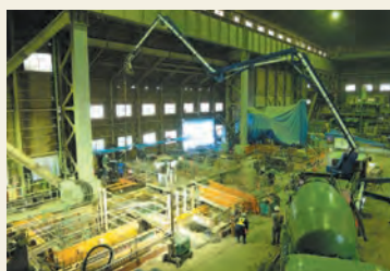
機械基礎工事
