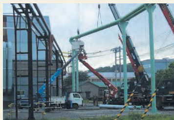
配管敷設工事
