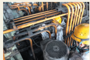
鍛圧機器油圧配管の 点検・補修
