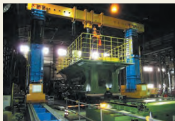
大型設備据付
