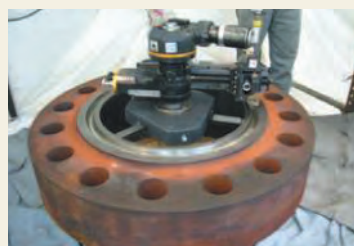
ガスケット溝の補修
