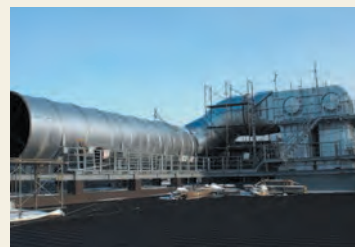
大型ダクト敷設工事
