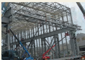
工場建屋建設工事
