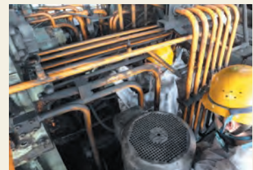
鍛圧機器油圧配管の 点検・補修
