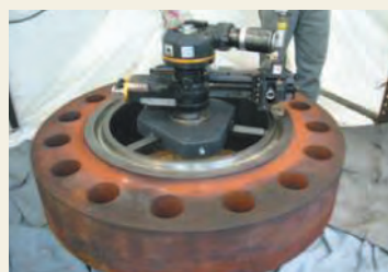
ガスケット溝の補修
