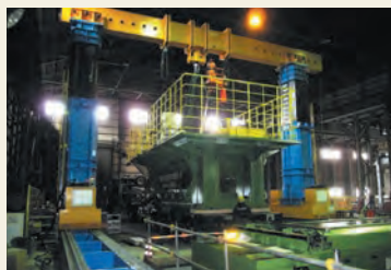
大型設備据付
