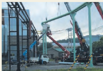
配管敷設工事
