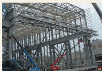
工場建屋建設工事
